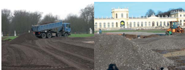
Abbildung 5 Einsatz von RC-Frostschutzmaterial unterhalb eines Ausstellungspavillons der Dokumenta XII vor der Orangerie in Kassel
